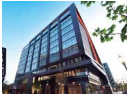
BLOC 83, CAROLINA DEL NORTE ARQUITECTO: GENSLER CONSTRUCTOR: WHITING - TURNER
