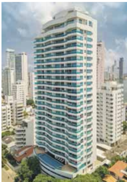
PUERTO VELERO, CARTAGENA ARQUITECTO: ROSA HELENA GÓMEZ CONSTRUCTOR: CONSTRUCTEC
