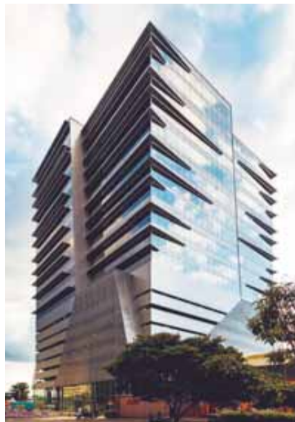
RIVANA, MEDELLÍN ARQUITECTO: HEMBERT PEÑARANDA - OFICINA ARCHITETTI. CONSTRUCTOR: BIENES & BIENES CONSTRUCTORES
